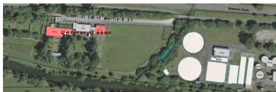
Bild: Kläranlagen-Areal als Beispiel für eine mögliche PV-Nutzungsfläche
