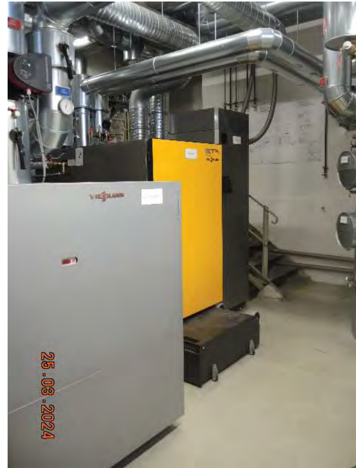
Pelletkessel (gelb) und Gaskessel (grau), untere Ebene
